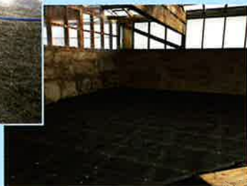
■ 敷設前の脱臭層
