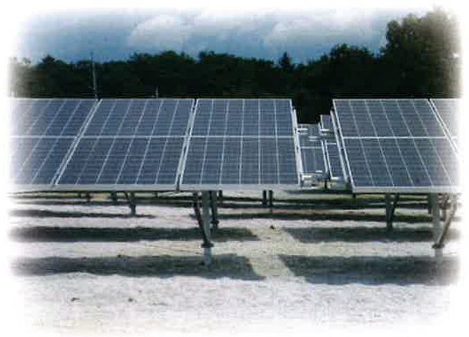
施行後 ポーラスα施設
