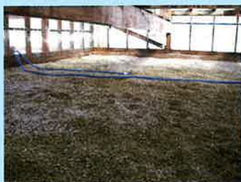
■『ポラスα ® 』を敷設した脱臭層
